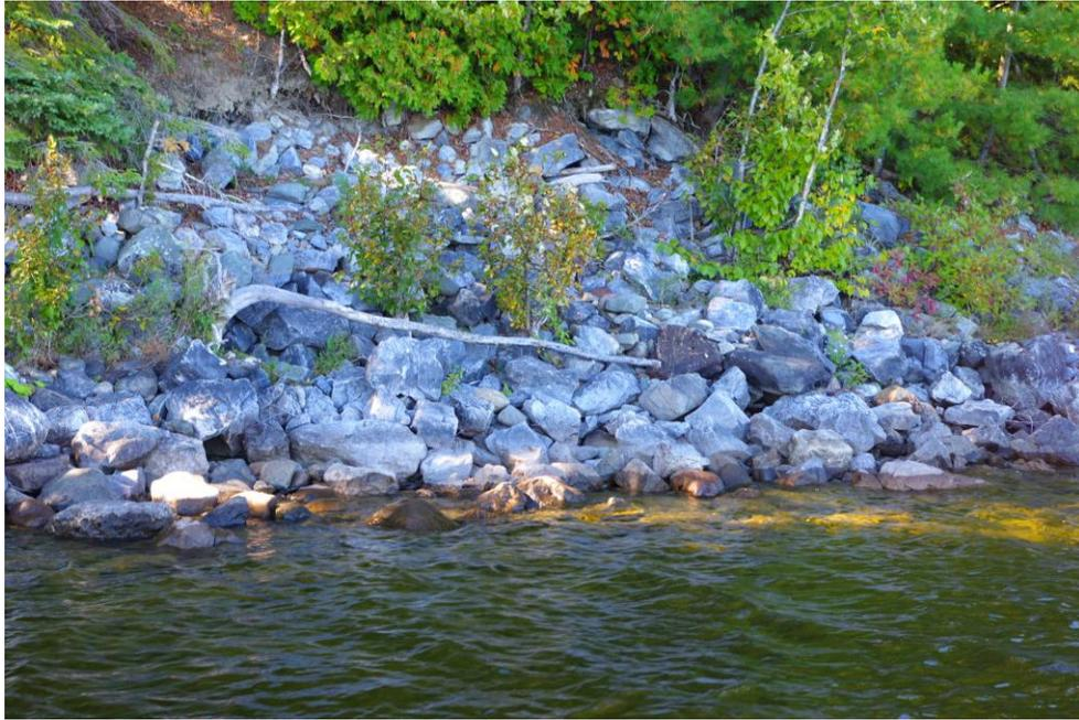
*Photo 5 Les rives du secteur Pointe-aux-Trembles sont recouvertes de pierres de gros calibre mises en place lors de la construction de l'ancien chemin de fer.*
