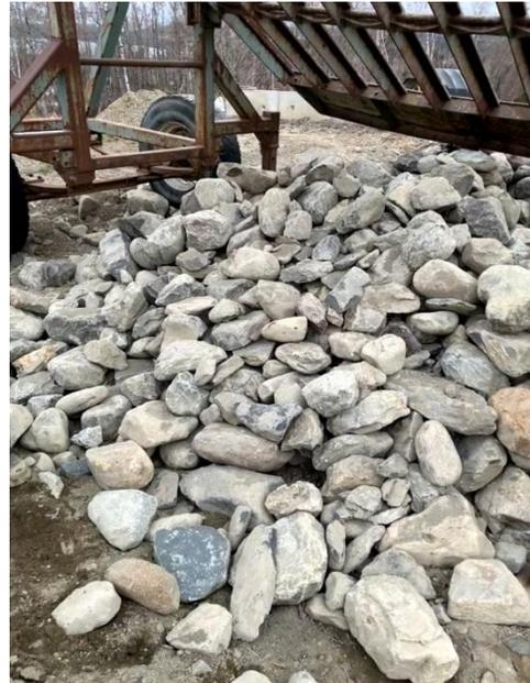
**Photo 3-2 : Aire d'entreposage pour le nettoyage naturel des pierres utilisées lors des travaux d'aménagement de frayère**
